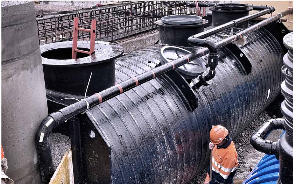
Einbausituation Fettabscheider EasyClean ground Auto Mix & Pump NS 30
